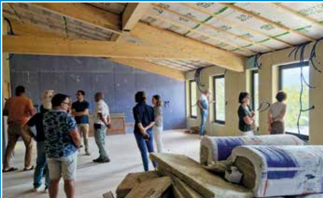
Visite du chantier du Tartaix
