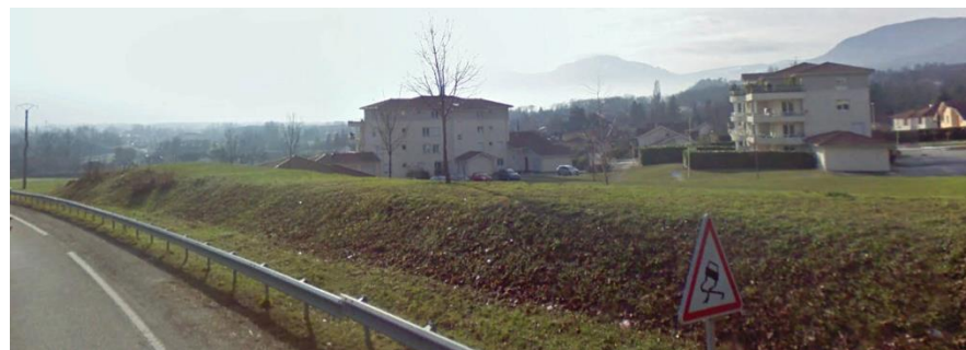
Arrivée sur la partie amont de la voie en S depuis St Ismier – Google Earth
